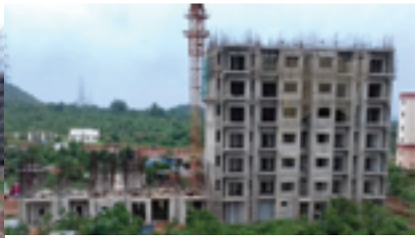
टाइप-बी 3 और बी 4 आवास: बी 3 में तल मंजिल छत स्लैब पूरा हुआ और बी 4 में तीसरी मंजिल की छत स्लैब पूरा हुआ
