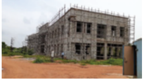
SHSSM पहली मंजिल छत स्लैब पूरा हो गया है और अंतिम दौर का काम प्रगति पर है
