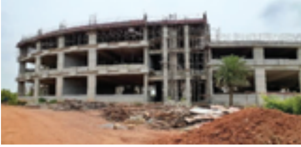
एलटीसी - 2 : पहली मंजिल छत स्लैब पूरा तल और पहली मंजिल में ब्लॉक कामप्रगति पर है
