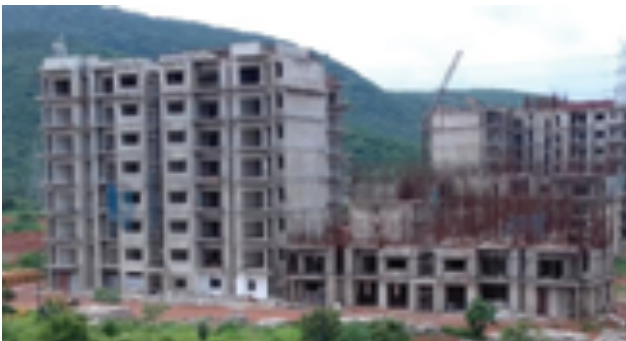
टाइप-बी 1 और बी 2 आवास: 6वीं मंजिल की छत का स्लैब पूरा
