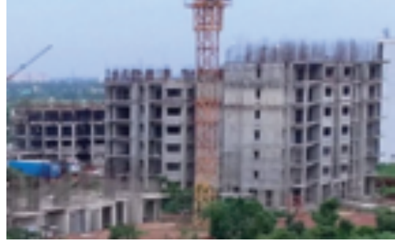
टाइप C3 आवास :तीसरी मंजिल छत स्लैब पूरा हुआ है
