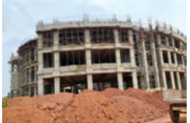
एलटीसी - 1: दूसरी मंजिल छत स्लैब प्रगति पर है और तल मंजिल, पहली मंजिल में ब्लॉक काम प्रगति पर है
