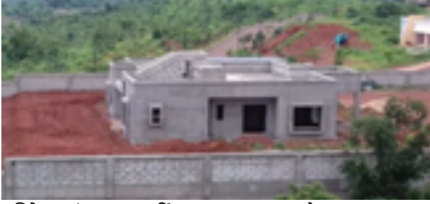
निदेशक बंगला प्लास्टरिंग का काम चल रहा है
