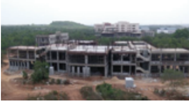
SEOCS पहली मंजिल छत स्लैब प्रगति पर है, तल मंजिल और पहली मंजिल में ब्लॉक काम प्रगति पर है
