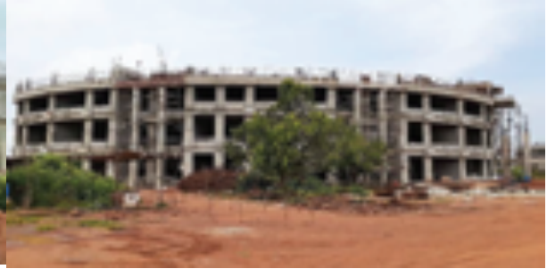
एलटीसी - 3: दूसरी मंजिल की छत स्लैब का काम प्रगति पर है, तल और पहली मंजिल पर काम चल रहा है
